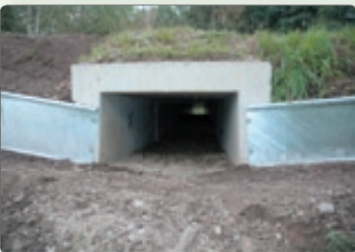
Neu eingebauter Kleintier- tunnel mit Leitanlage
